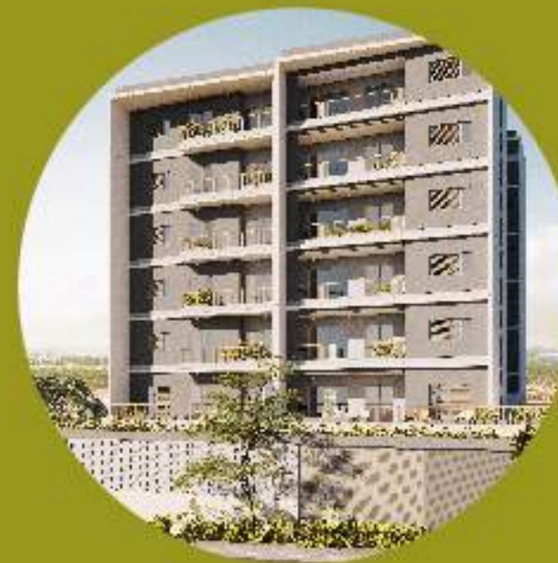
VILLAGE TULIPA 28 UNIDADES EM CONSTRUÇÃO
